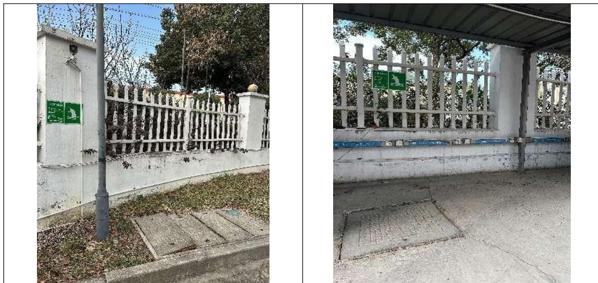
图 4-2 废水和雨水标识牌
