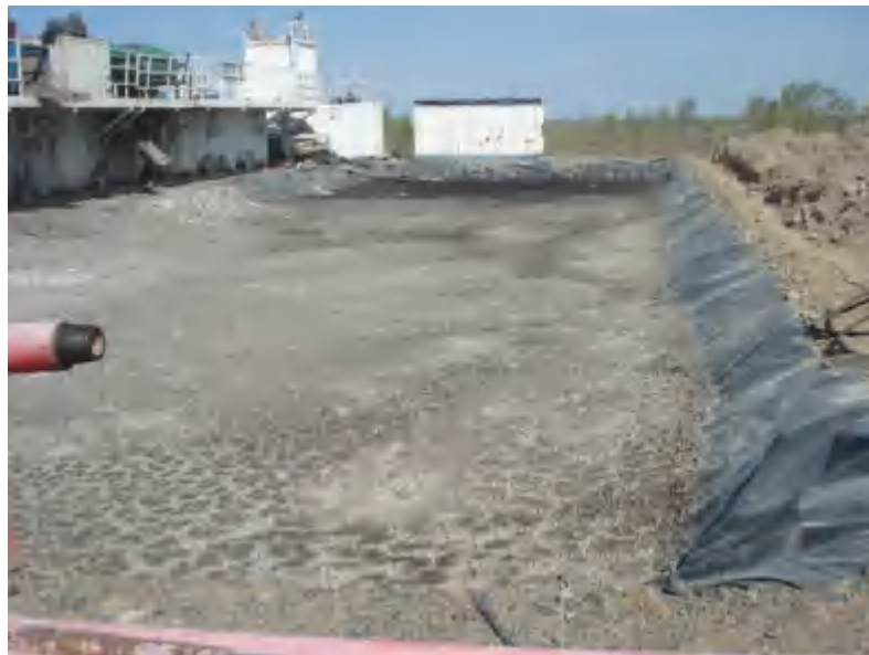
钻井期间泥浆池
