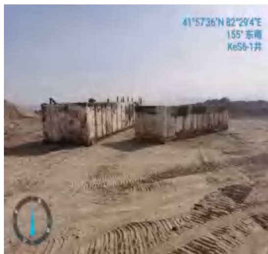
钻井设施、临时设备拆除
