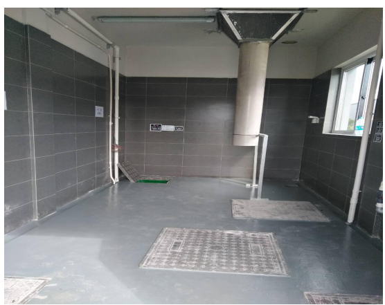
图 4-11 危废仓库（内部）
