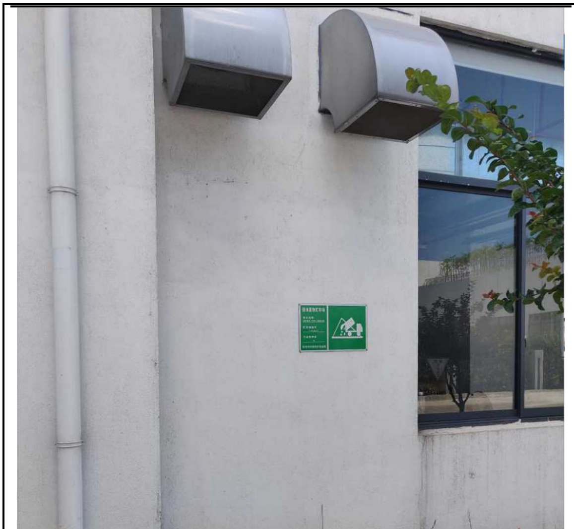
图 4-2 危废仓库及一般固废照片
