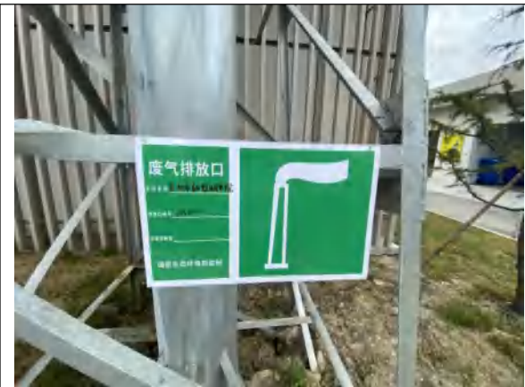
图 4-11 污水站排气筒
