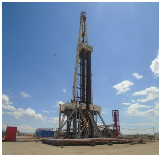
钻井期间井场
