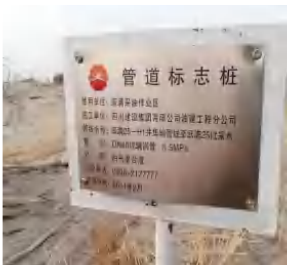
管道桩标识牌
