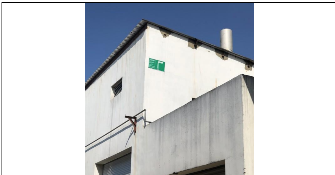
废气排气筒标识牌
