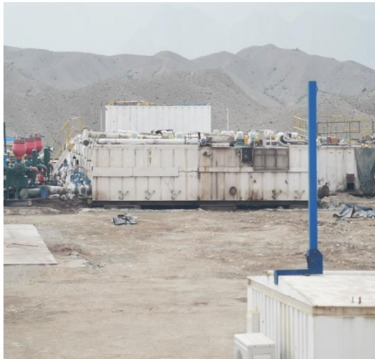
钻井期间井场设施
