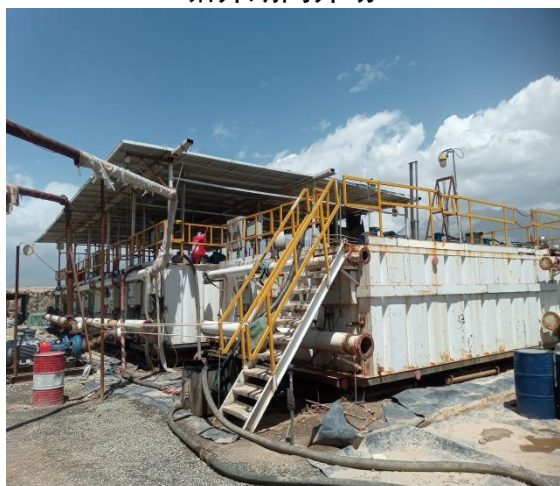
钻井期间井场设施
