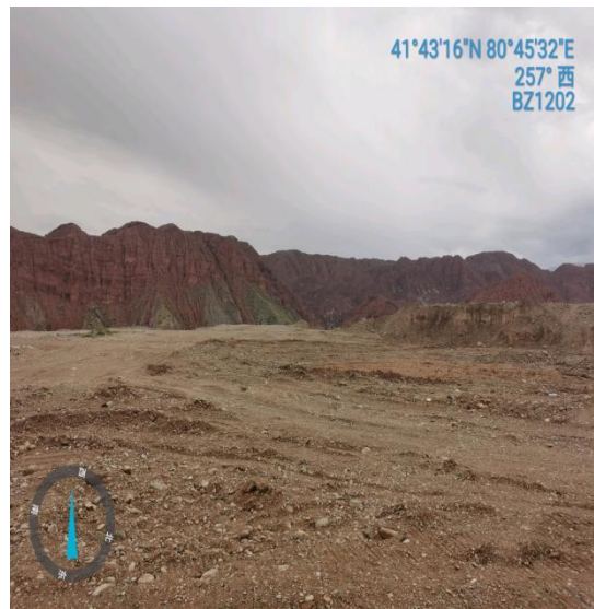
钻井完成后井场恢复
