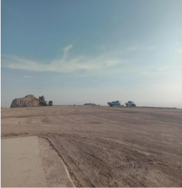
钻井完成现场修复
