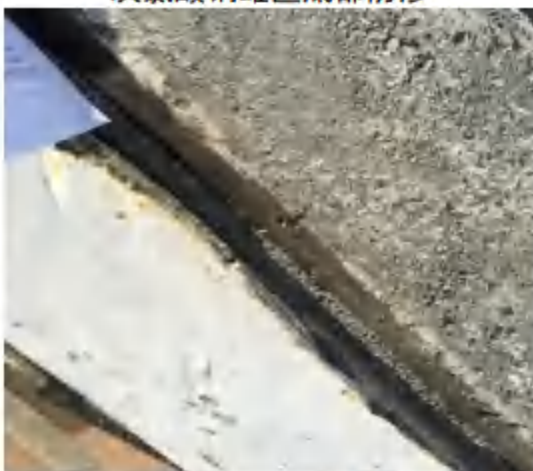
罐区防渗措施（土工布+土工膜）
