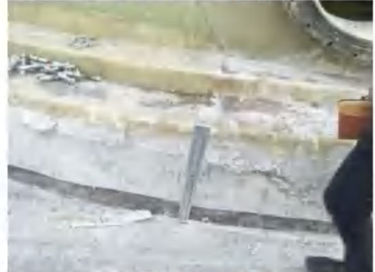
罐体防腐防渗
