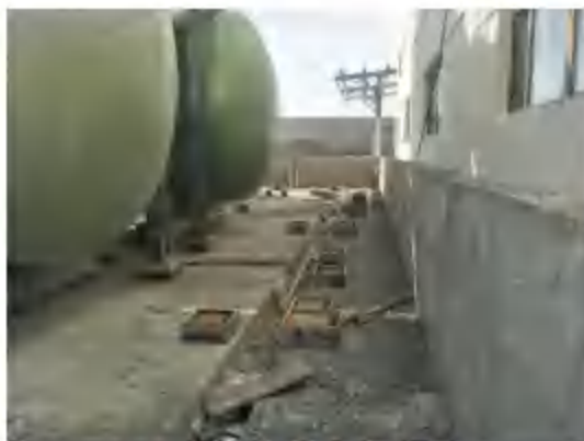
次氯酸钠罐区底部防渗
