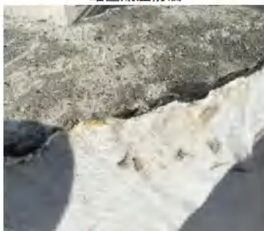
罐区防渗措施（土工布+土工膜）
