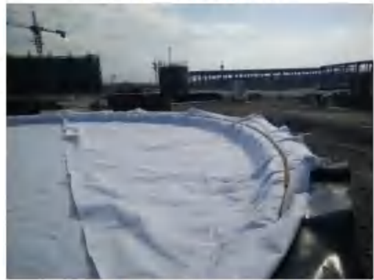
甲苯罐区土工布土工膜铺装
