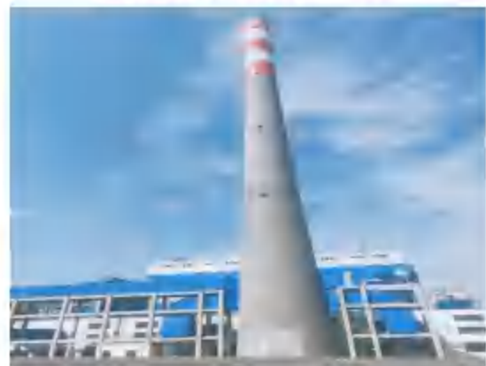
动力站锅炉烟气排口
