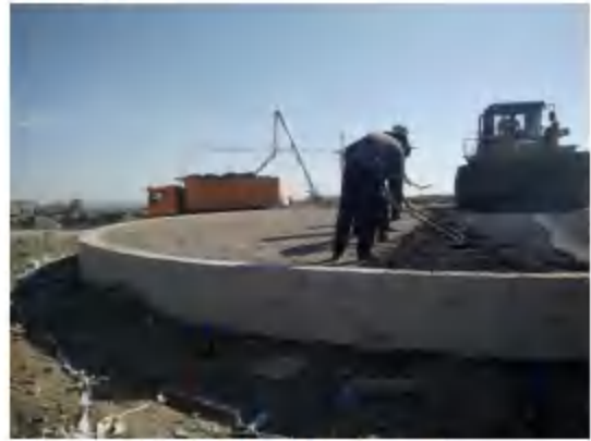
甲苯罐区铺设沥青砂
