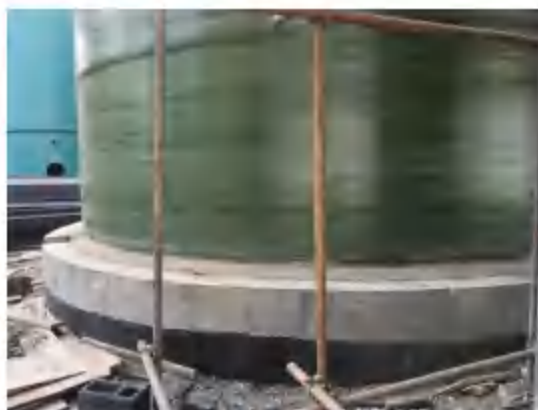
罐区底座防腐
