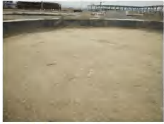
甲苯罐区罐内做级配砂石
