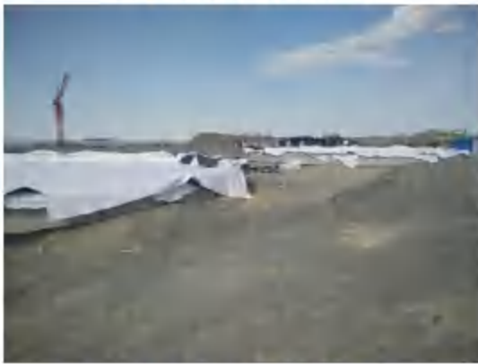
甲苯罐区土工布土工膜铺装
