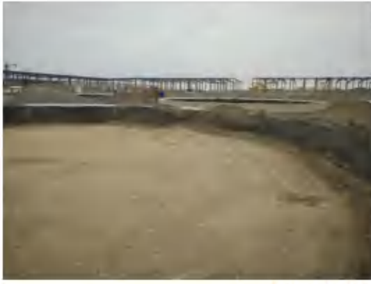
甲苯罐区罐内做级配砂石
