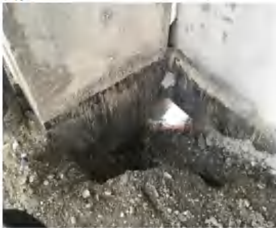
煤库沥青防腐
