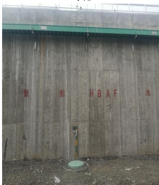
污水处理装置
