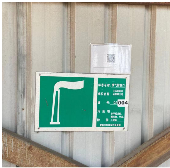
废气排气筒标识牌
