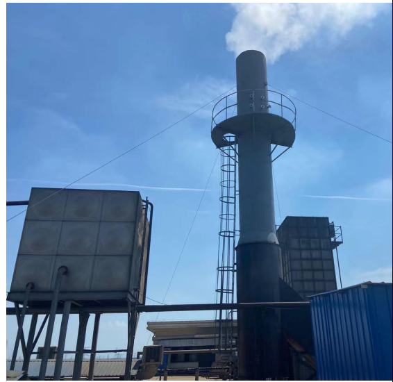
排气筒及采样平台
