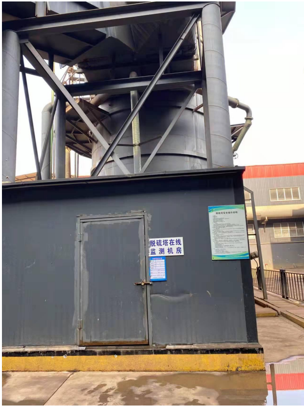
脱硫塔在线监测房
