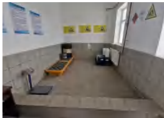
围堰及防渗措施
