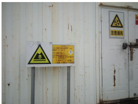
废机油暂存间
