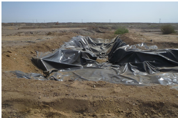
钻前泥浆坑铺设防渗膜
