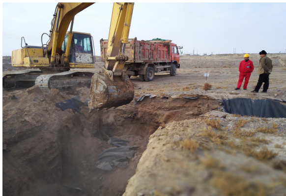
废弃泥浆坑拉运作业
