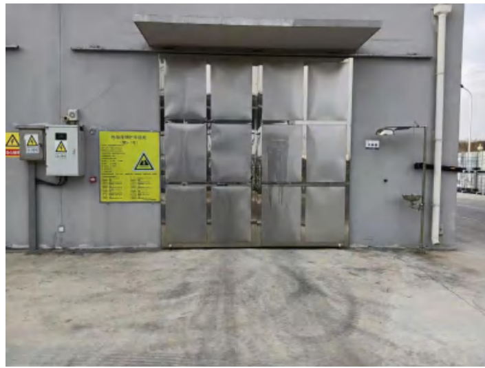
图 4-9 危废仓库外照片
