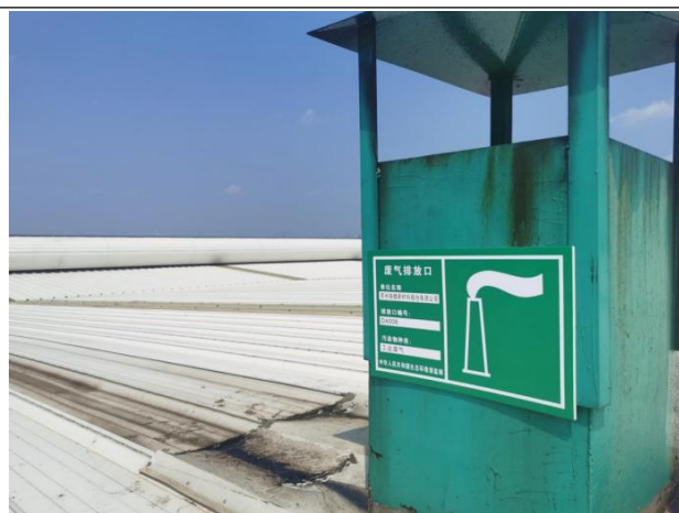
图 4-10 压延车间 6#排气筒
