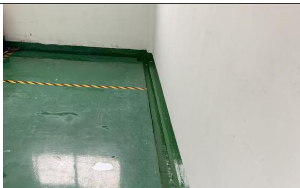
图 4-18 危险固废仓库导流沟
