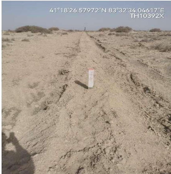
管线临时占地恢复
