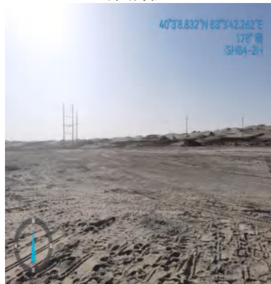
临时占地恢复
