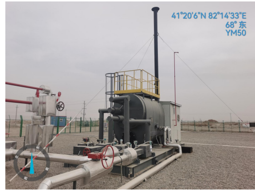
YM50 井场加热炉
