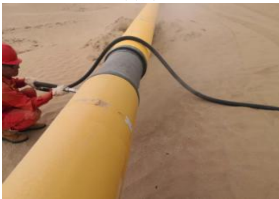
喷砂除锈作业
