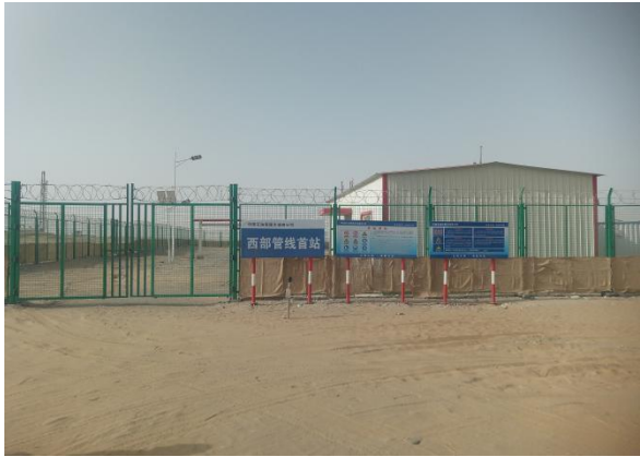
西部管道首站
