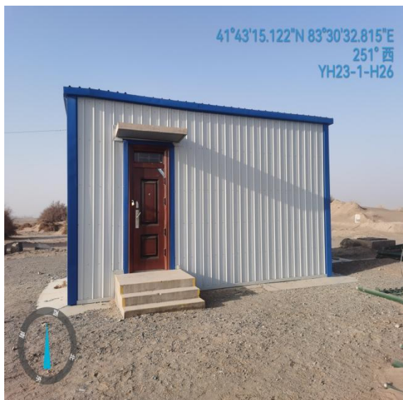
井场撬装设施
