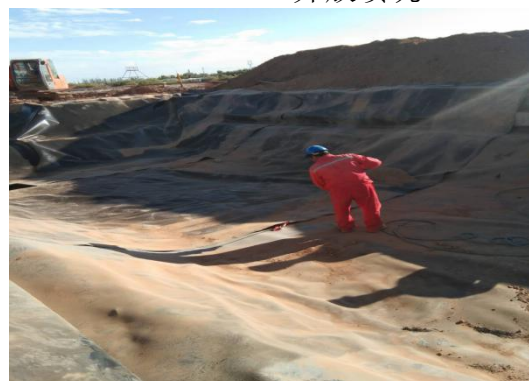
放喷坑防渗膜铺设
