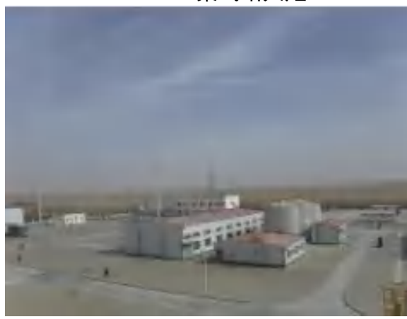
塔三联污水处理装置
