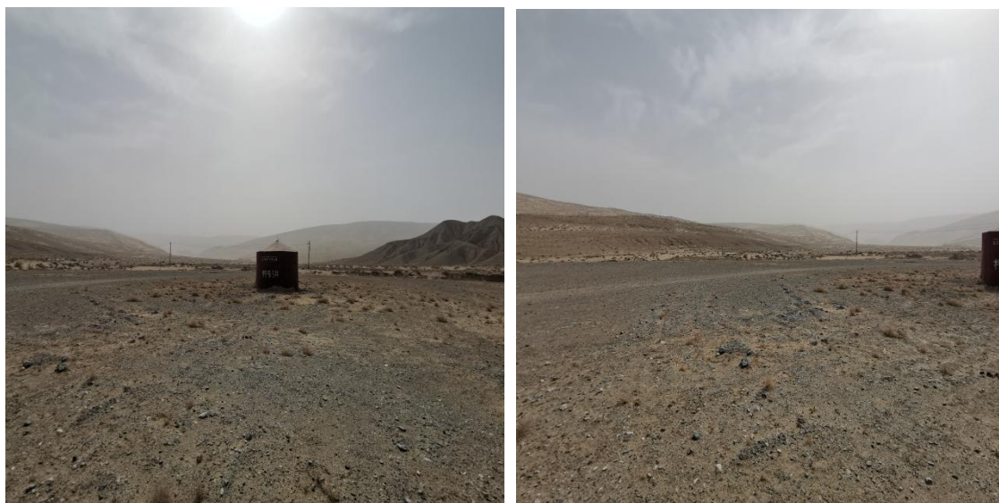
钻井完成后井场恢复
