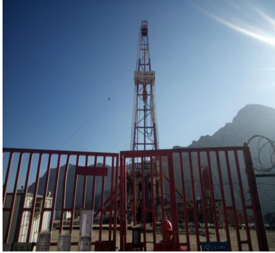
钻井期间井场
