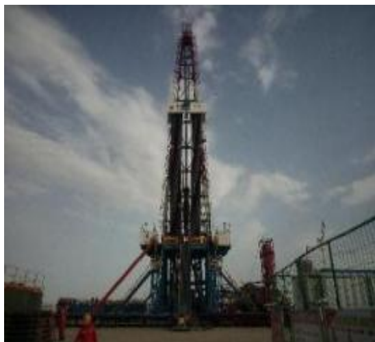
钻井期间井场
