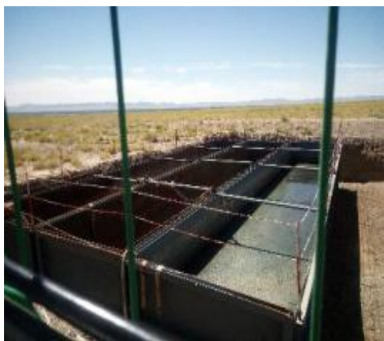
钻井期间井场设施
