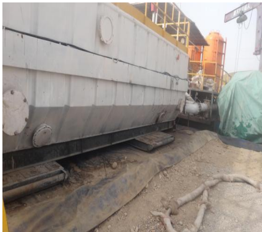
钻井期间井场设施
