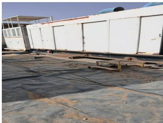
设备地面铺设防渗膜
