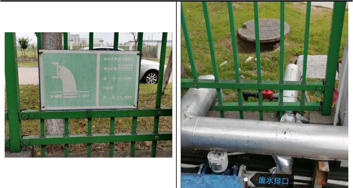
图 4-2 废水排口照片
