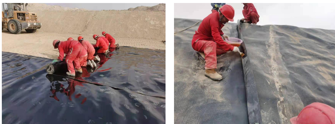
防渗膜施工作业
