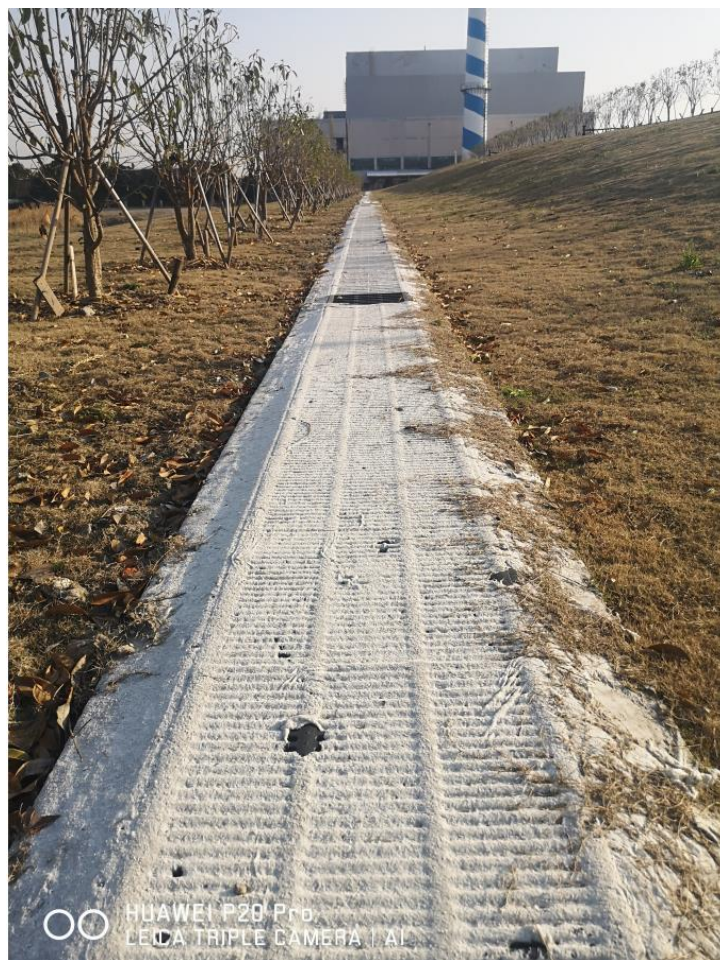
图 3-14 场区内外雨水导排沟照片
