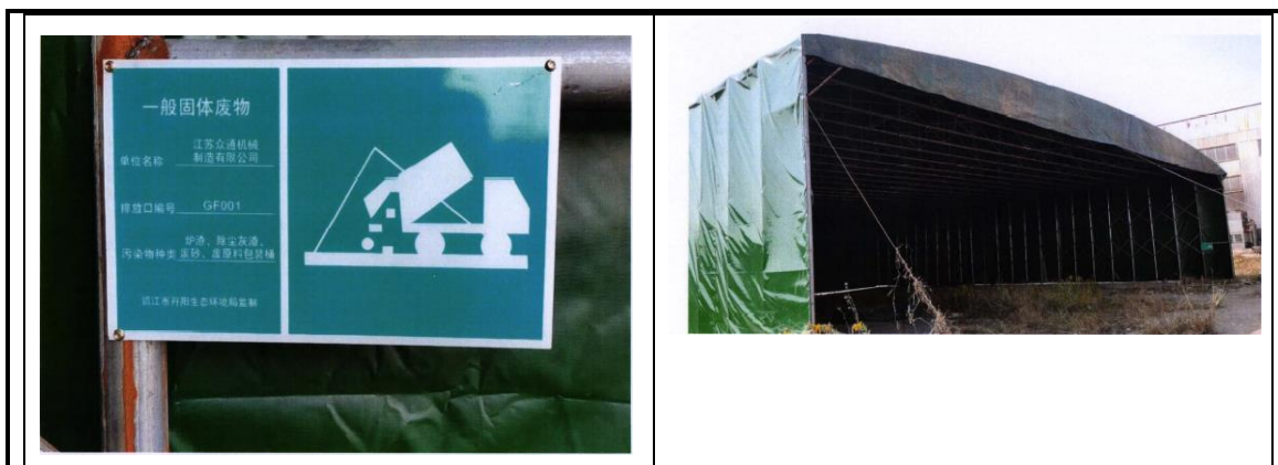
一般固废堆场
