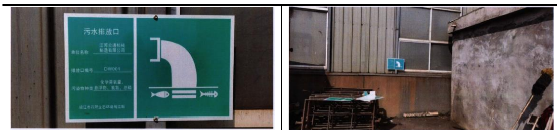
图 4-1 废水排放口照片
