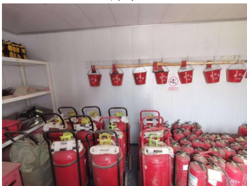
钻井期间消防设施
