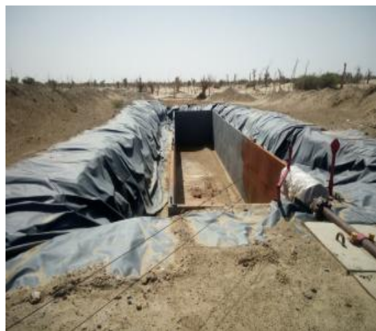
钻井期间井场设施
