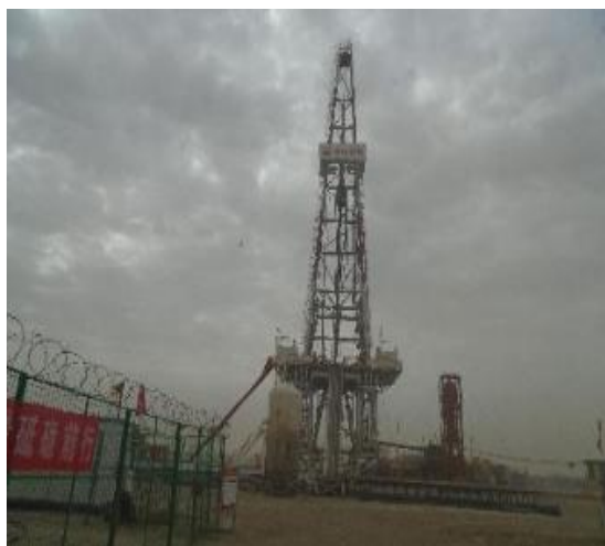
钻井期间井场
