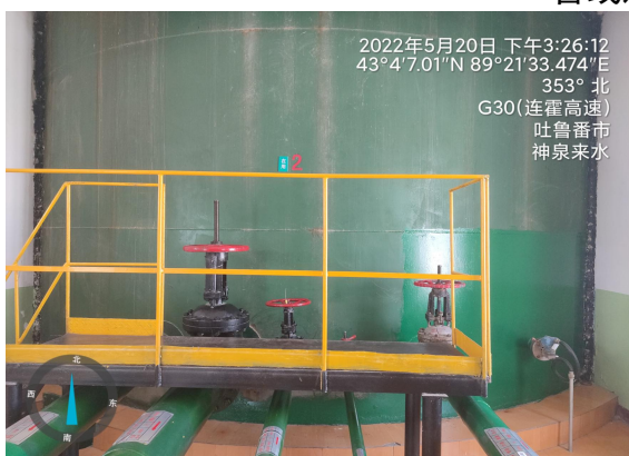
污水缓冲罐及输水管线进口
