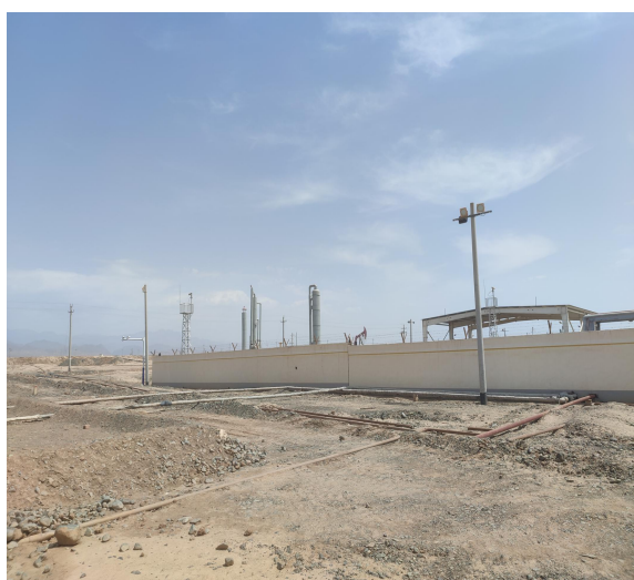
输水管线临时占地恢复
