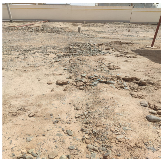
输水管线临时占地恢复
