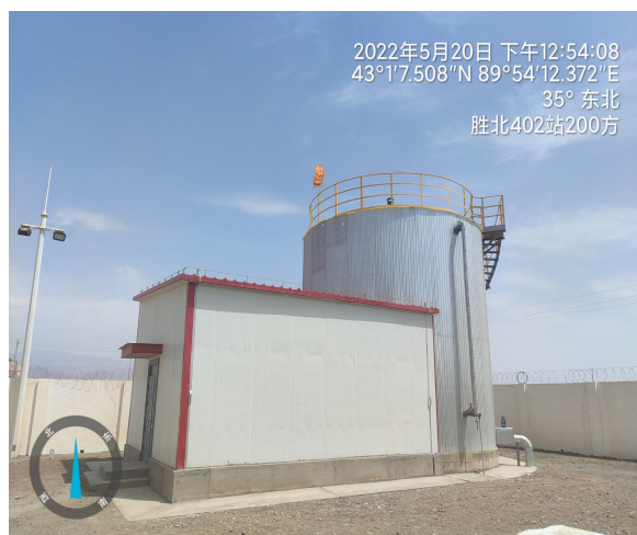
200 立方米污水接收罐
