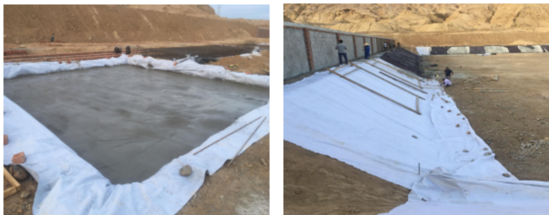
防渗膜施工作业
