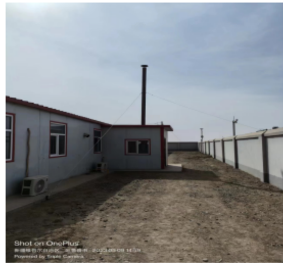
天然气热水锅炉排口
