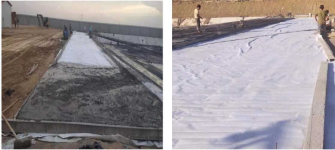
防渗膜施工作业
