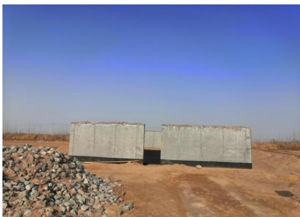
放喷池防火墙
