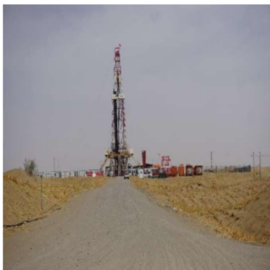
钻井期间井场
