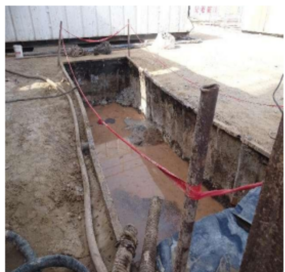
泥浆不落地设备
