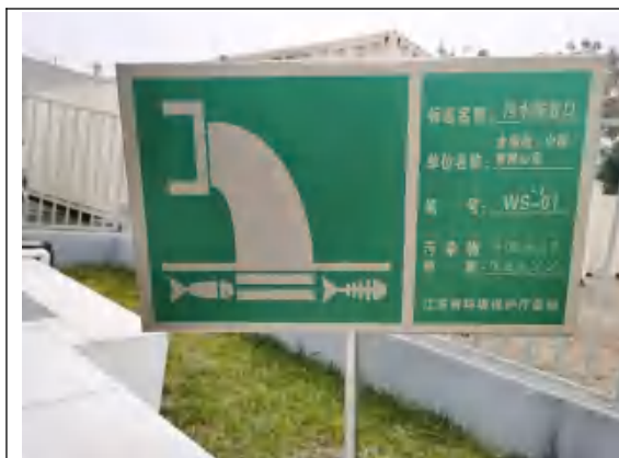
图 4-2 废水排放口标识牌照片
