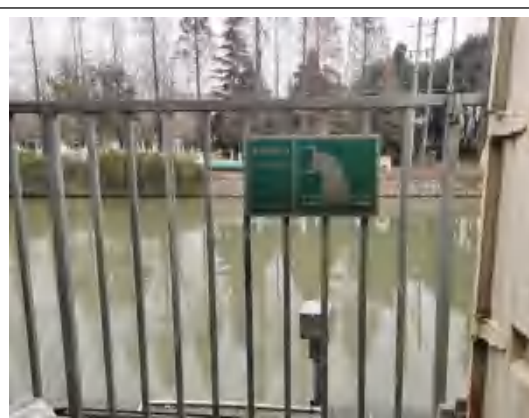
图 4-3 雨水排放口标识牌照片
