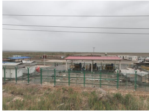
YH15 注水井泵房
