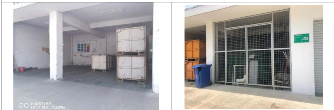
图 4-8 厂区一般固废暂存区
