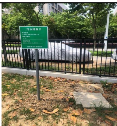
图 4-1 厂区污水排口
